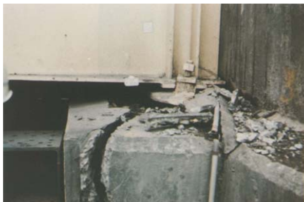
RC橋脚・支承部周辺等ねばりの少ない部位の損傷
