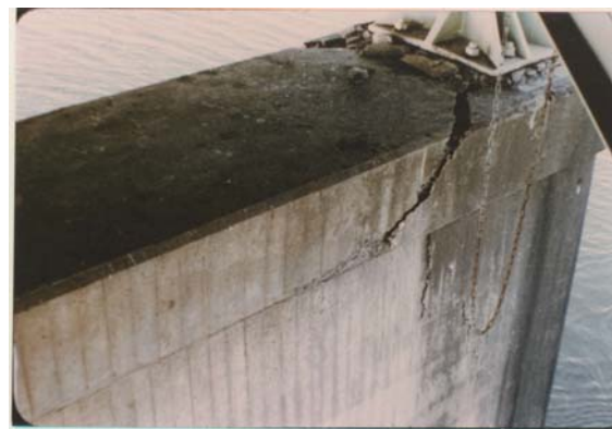
RC橋脚・支承部周辺等ねばりの少ない部位の損傷
