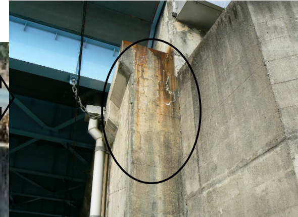
跨線橋たて壁側面
