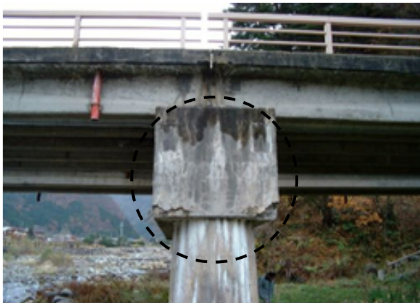
道路橋橋脚の柱頭部
