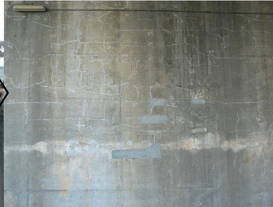
跨線橋たて壁正面
