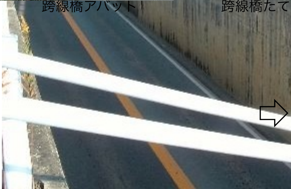
鉄道アンダーパス・側壁
