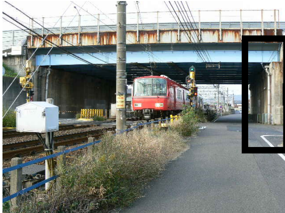
跨線橋アバット
