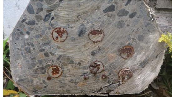
写真-5 グラウト充填状況(撤去PC桁)
