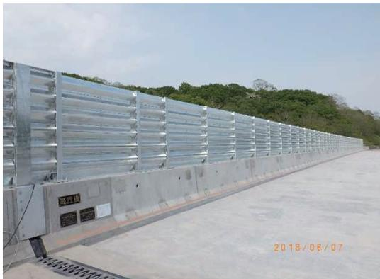
写真-3 飛雪防止柵設置状況
