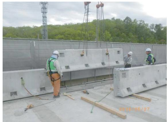
写真-2 EMC壁高欄の架設状況
