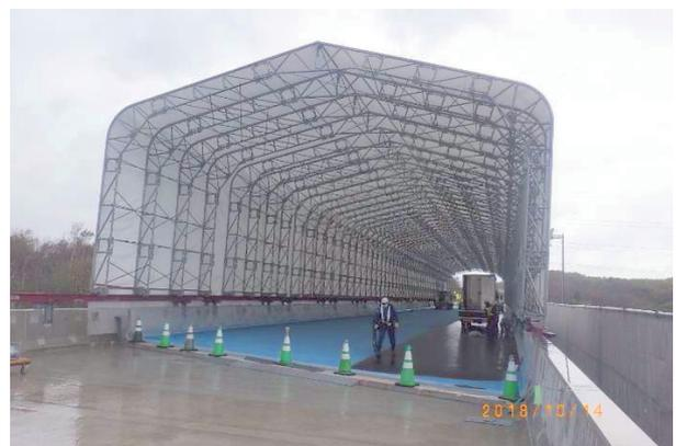
写真-10 雨天時の床版防水施工状況
