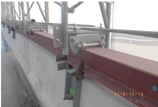
写真-9 壁高欄上のH型鋼レール
