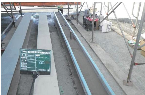
写真-4 鋼桁防錆剤 試験施工状況
