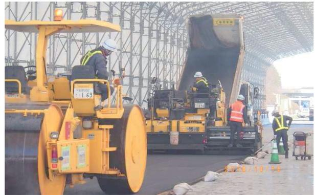
写真-8 養生上屋内のダンプアップ状況
