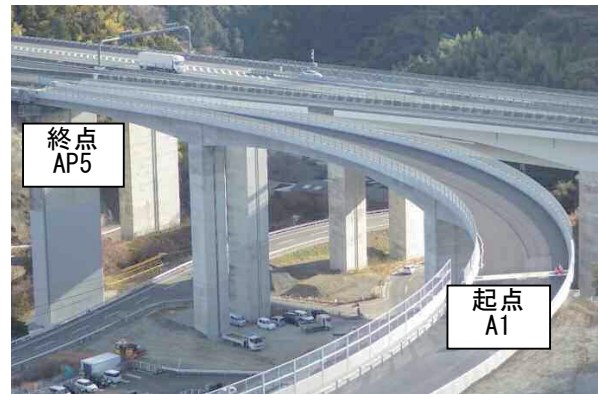
写真－1 Eランプ橋全景
