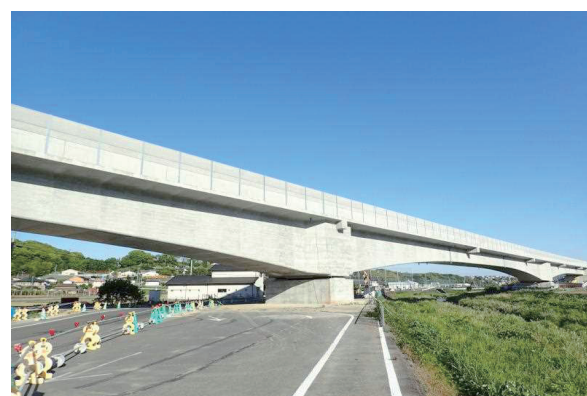
写真 - 2 橋梁本体 完成写真
