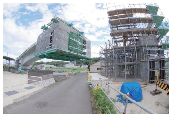
写真 - 1 作業台上昇後の状況
