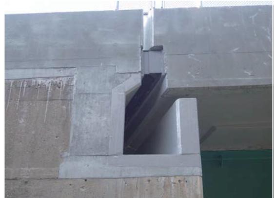
写真-2 セットバックジョイント構造
