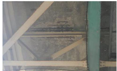
写真-1 床版下面の劣化状況
