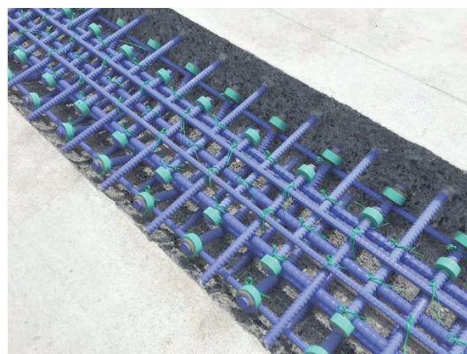
写真-2 MuSSL 工法継手
