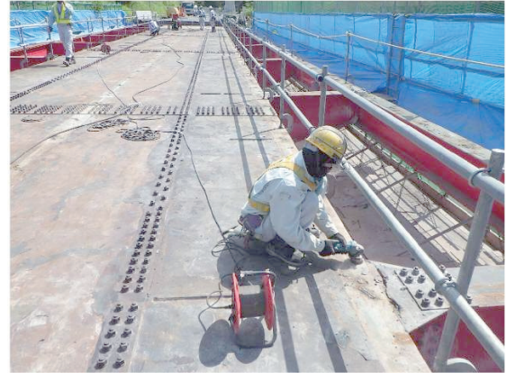
写真-5 素地調整作業状況
