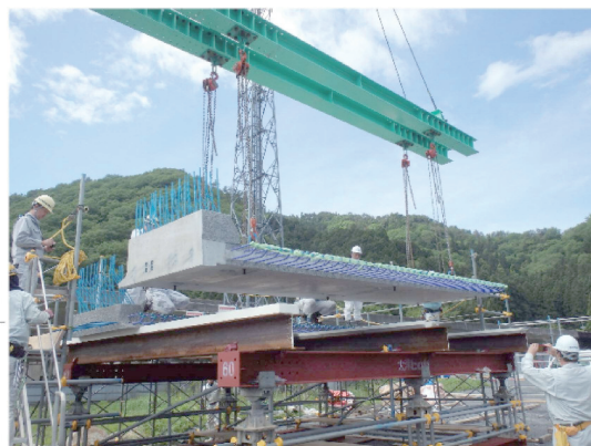
写真-3 架設施工性試験状況
