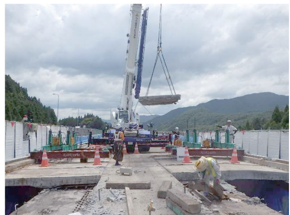
写真-4 既設床版 撤去状況
