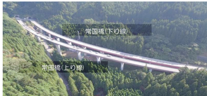
写真-1 橋梁全景
