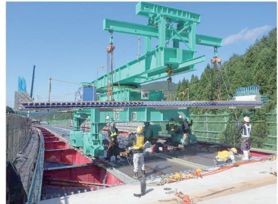
写真-6 PCaPC 床版 架設状況
