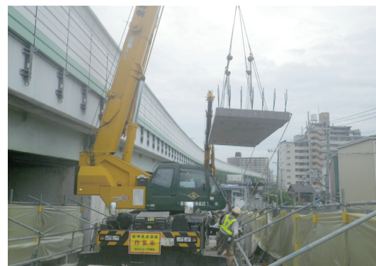
写真-1 床版架設状況
