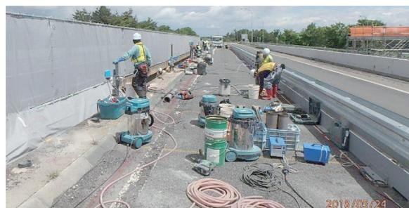
写真-1 コア削孔状況（渡り線施工時）
