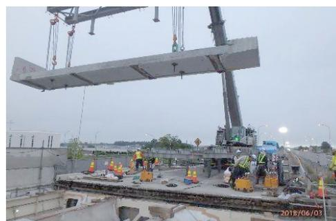
写真-3 伸縮装置と床版の撤去状況
