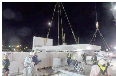
写真-2 壁高欄と床版の撤去状況
