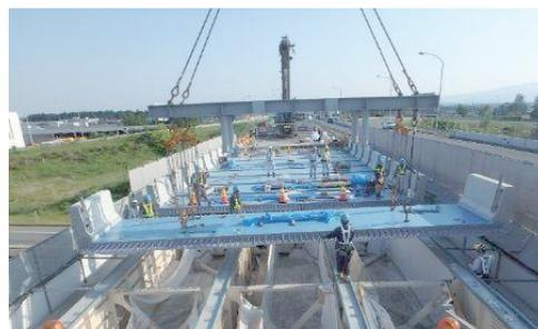
写真-5 PC床版架設状況
