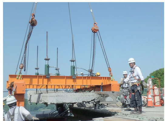
写真-3 床版撤去状況
