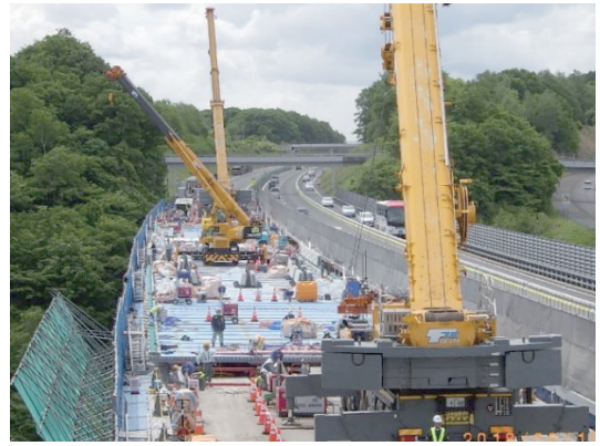
写真-4 架設クレーン配置状況
