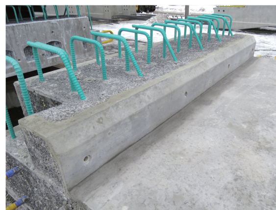
写真-2 PCaPC 床版地覆部立上げ
