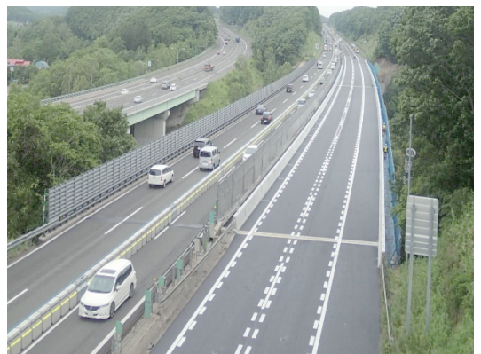
写真-7 完成写真
