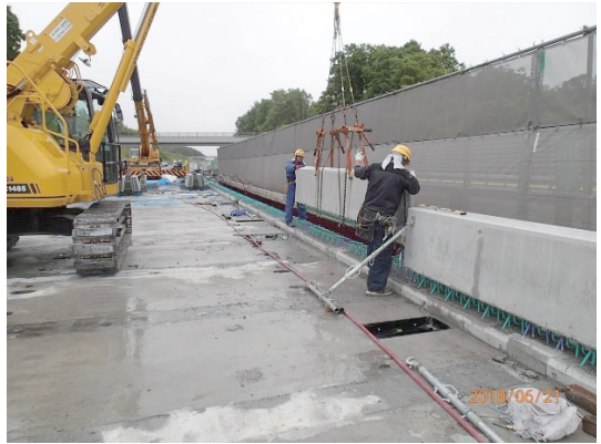
写真-5 PCa 壁高欄設置状況
