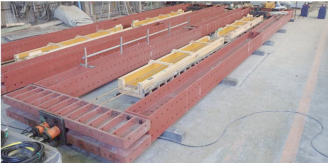
写真－１ 試験体製作状況
