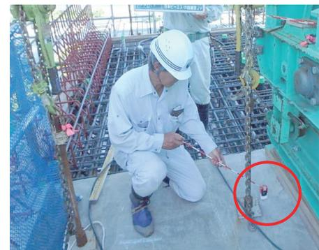
写真-2 計測用プリズム
