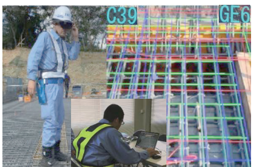
写真-4 現場と事務所の遠隔管理
