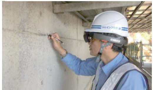
写真-2 アンカー位置出し(施工前)
