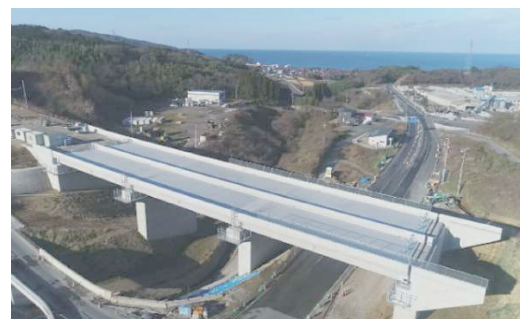
写真-6 完成写真
