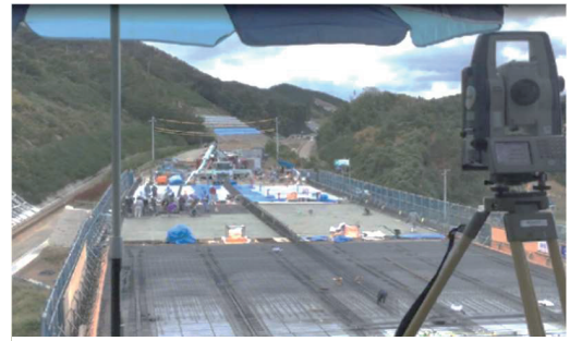
写真-5 TSによる品質管理
