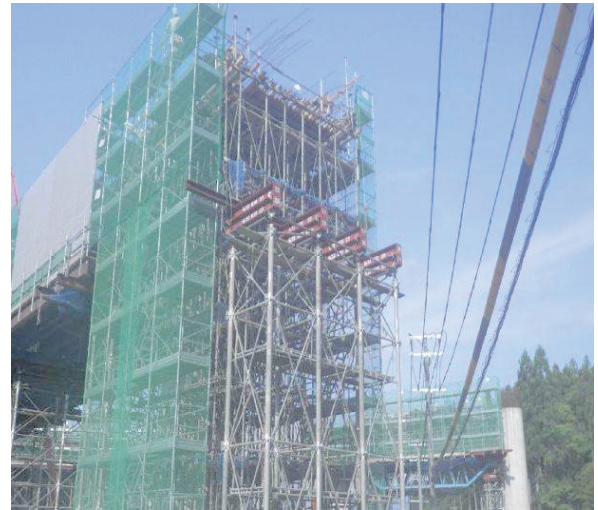
図-7 電柱移設後
