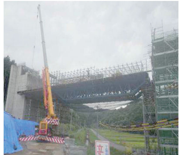
図-9 実施工写真
