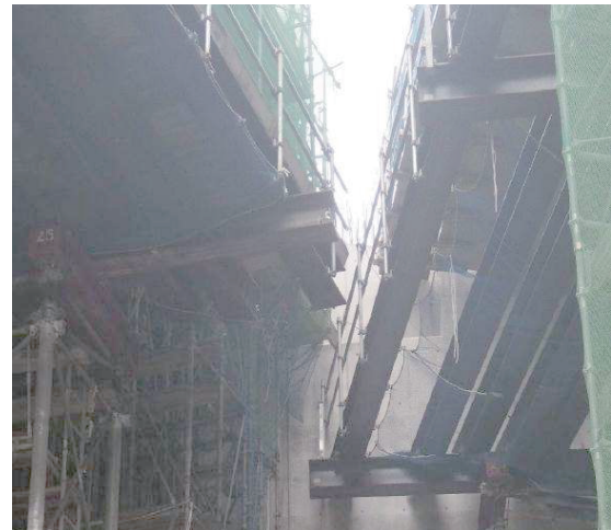
図-5 実施工写真
