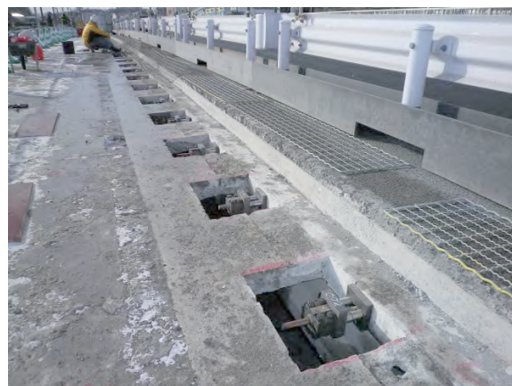
写真-8 中間定着完了（1次施工）
