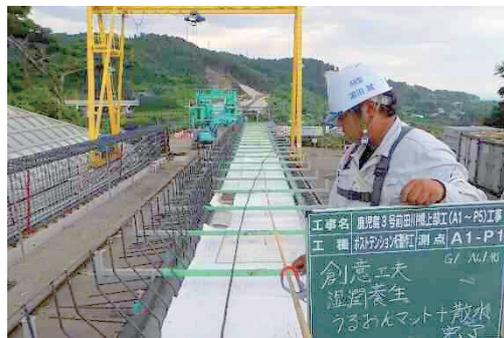
写真-4 散水養生状況
