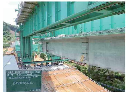
写真-1 主桁架設状況
