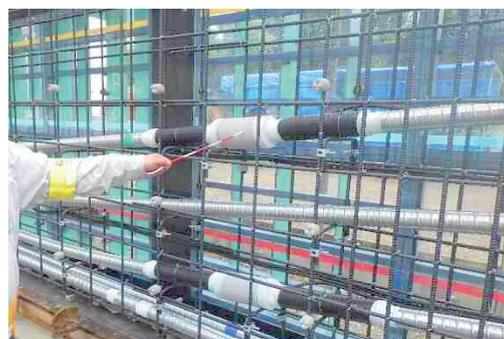
写真-5 EMセンサー設置状況
