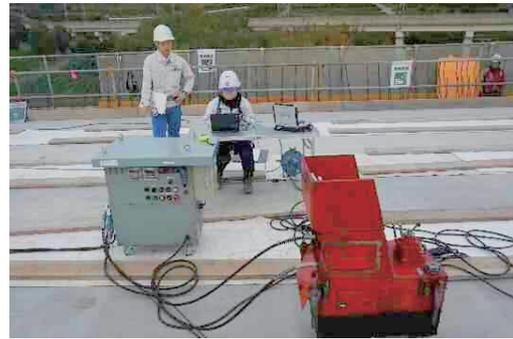
写真-7 床版横締めPCケーブルの自動緊張状況
