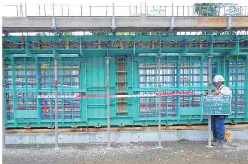
写真-3 透明型枠設置状況
