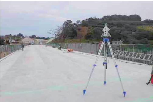
写真-8 床版面の出来形計測状況
