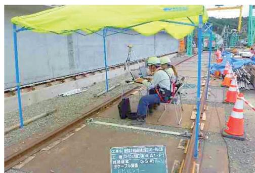
写真-6 EMセンサーによる計測状況
