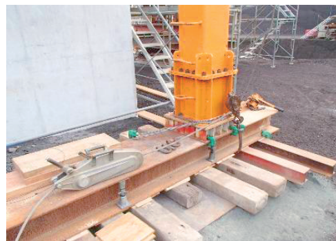
写真－9 架設門構固定
