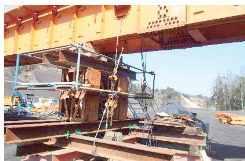
写真－7 架設桁とベントの固定
