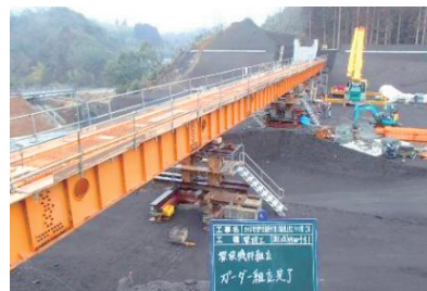
写真-5 架設桁設置完了
