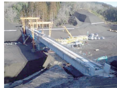
写真－12 架設完了
