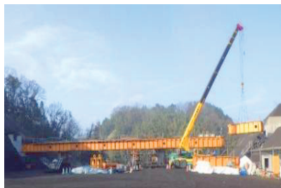
写真-4 架設桁引出し
