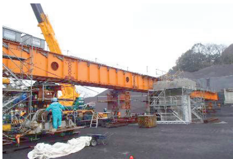
写真－6 架設桁引出し
