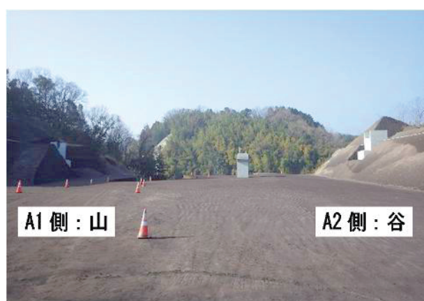
写真-2 施工ヤード(側面より)
