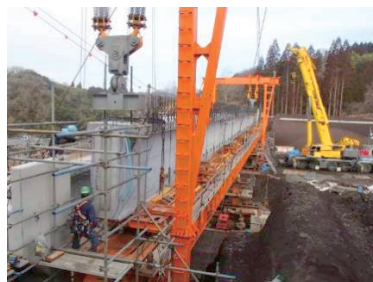
写真－11 主桁架設
