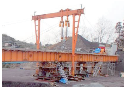
写真－8 架設門構設置
