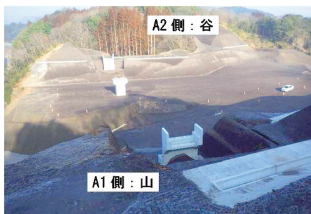
写真-1 施工ヤード(起点側より)
