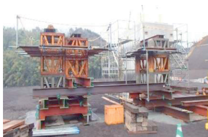
写真-3 ベント設置
