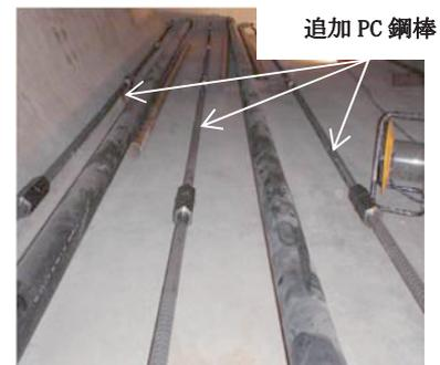
写真-1 PC 鋼棒補強状況
