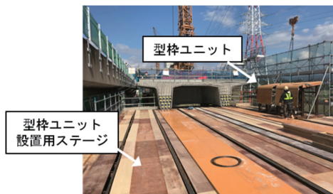
(d) 型枠ユニットの設置
