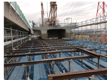
(c) 大引き材の設置
