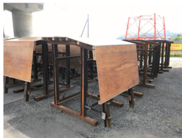
(a) 型枠ユニットの地組み
