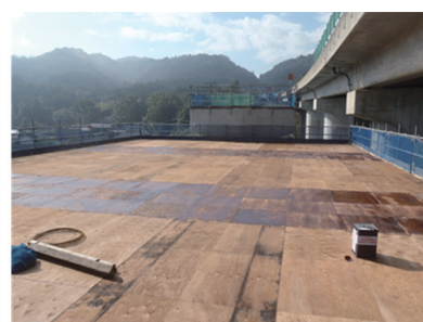
(c) 支保工ステージの完成
