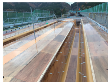
(e) 型枠の完成
