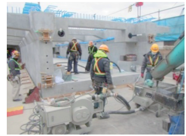
写真-5 底版モルタル充填状況
