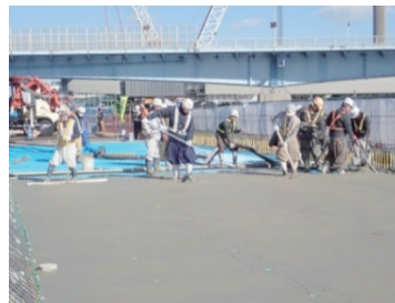
写真-7 床版打設状況
