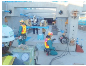
写真-4 外ケーブル緊張状況
