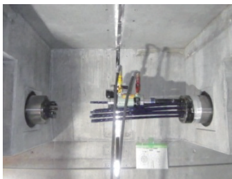
写真-9 外ケーブル緊張状況
