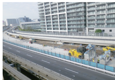
写真－1 セグメント架設全景
