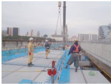
写真-6 PC板敷設状況
