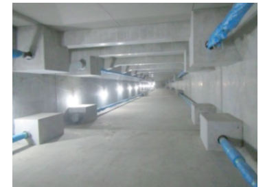
写真-8 ボックス内部の状況
