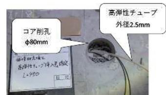
図-6 高弾性チューブの挿入 (充填不足長さ測定)
