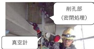
(b) 漏気部の探査
