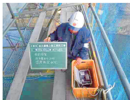
写真-10 コンクリート温度計測状況
