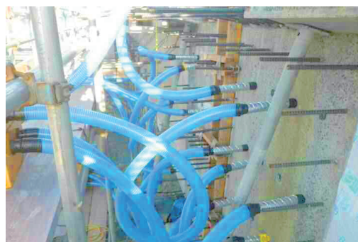
写真-8 エアークーリング状況
