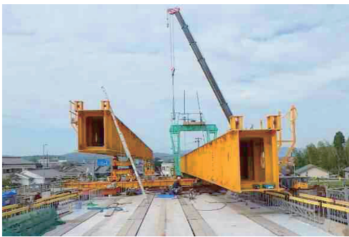
写真-4 架設桁の降下
