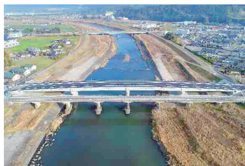
写真-11 完成した加久藤橋
