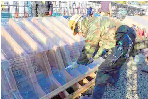
写真-6 継目部の漏水防止対策
