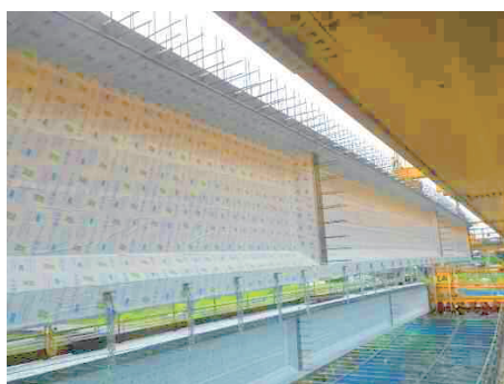
写真-9 保水養生テープ設置状況
