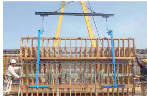
写真-7 型枠のパネル化
