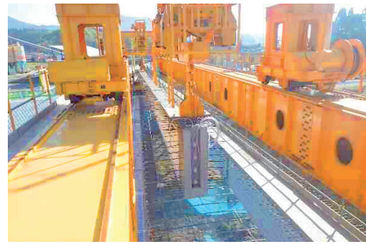
写真-1 架設状況
