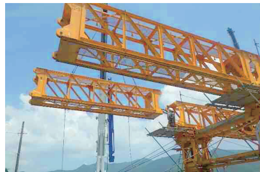
写真-3 解体状況
