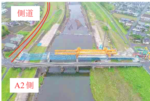
写真-2 側道交差状況
