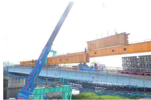
写真-5 架設桁解体状況
