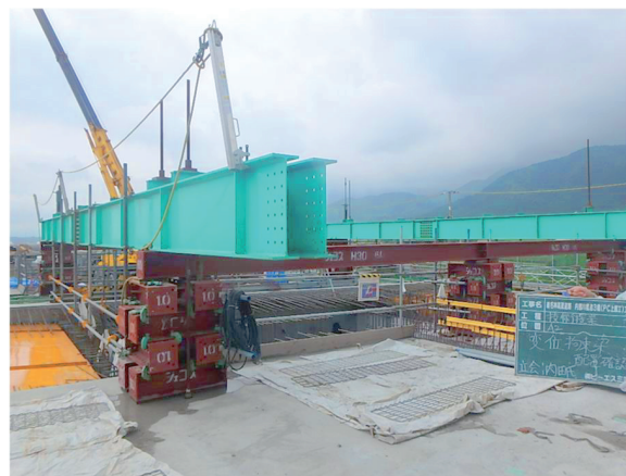
写真-2 変位拘束梁の設置状況
