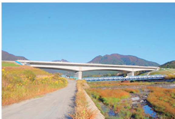
写真-3 完成写真
