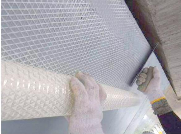
写真-7 コンクリート片剥落防止対策工施工状況
