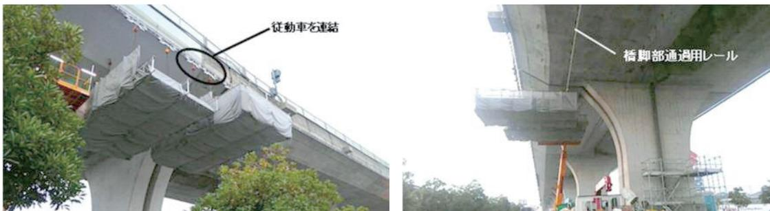
写真-3 移動式吊足場移動状況
