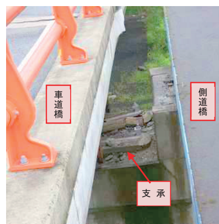
写真－2 側道橋との離隔
