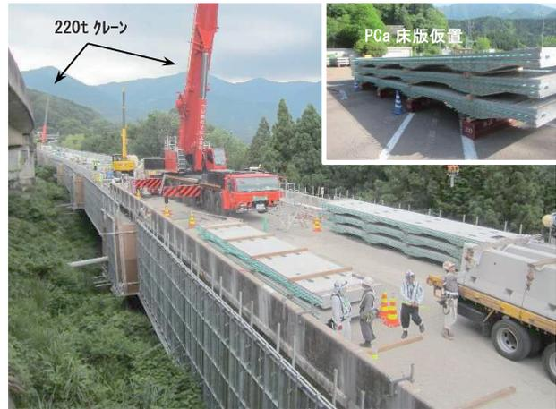
写真-3 PCa床版架設状況 (2方向施工)
