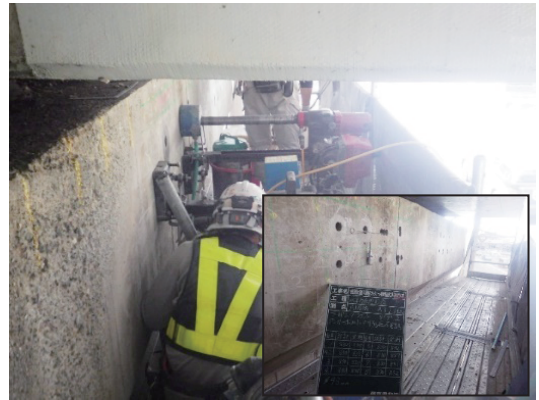
写真-2 コア削孔状況
