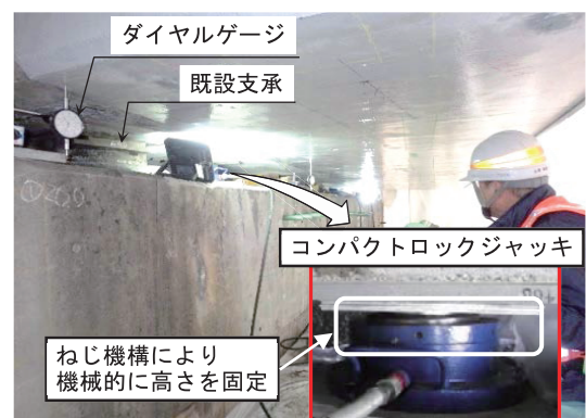
図-8 ジャッキアップ状況
