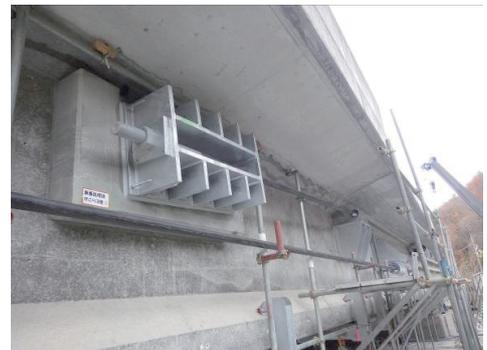
写真-5 外ケーブル緊張完了状況
