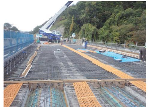
写真-3 床版の鉄筋組立状況
