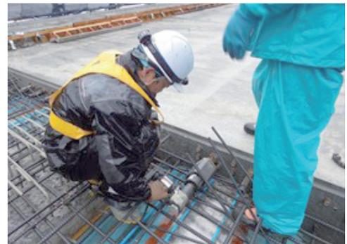
写真-4 中空PC鋼棒の緊張力導入
