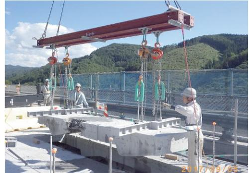
写真-2 主桁間床版の撤去状況
