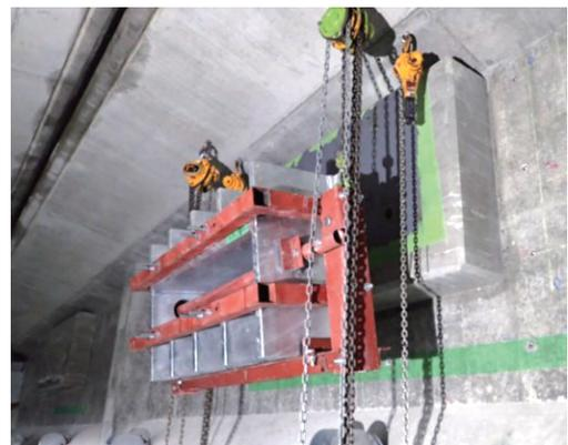
写真-1 定着装置設置状況
