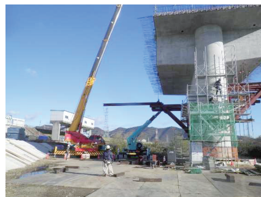
写真－3 大型ブラケット解体状況
