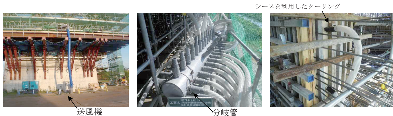
写真－5 パイプクーリング実施状況
