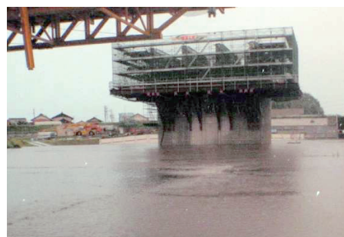
写真－3 柱頭部支保工(河川増水時)
