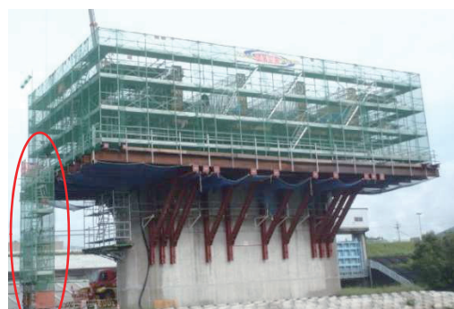
写真－2 柱頭部支保工(通常時)
