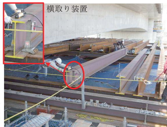
写真－4 H鋼解体状況
