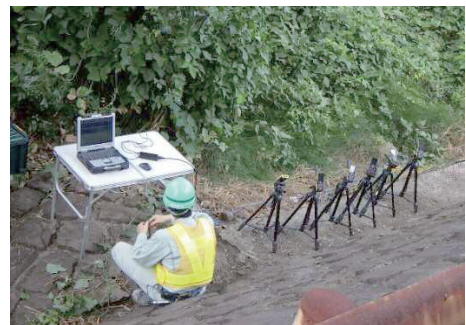
写真 - 3 たわみ測定状況
