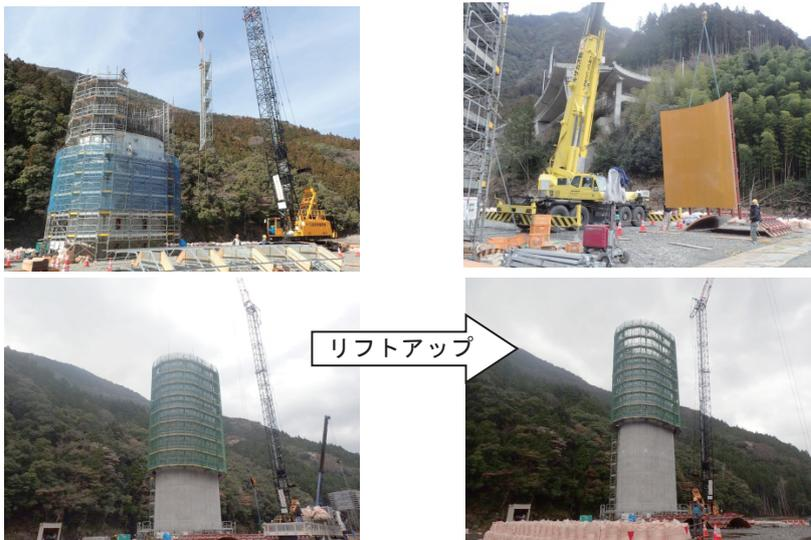
写真-1 型枠組立て状況写真
