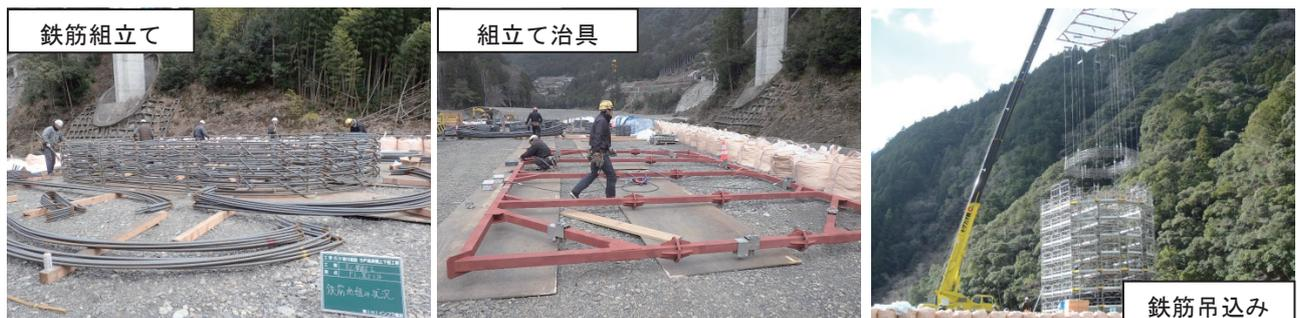
写真-2 鉄筋組立て状況写真
