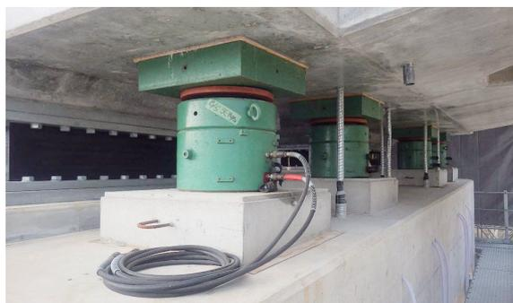
写真-6 仮固定施工完了
