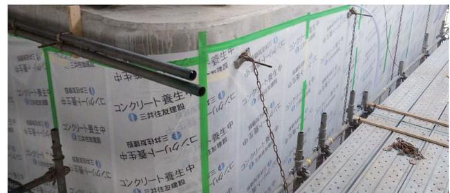
写真-3 保水養生テープ+気泡シート設置状況
