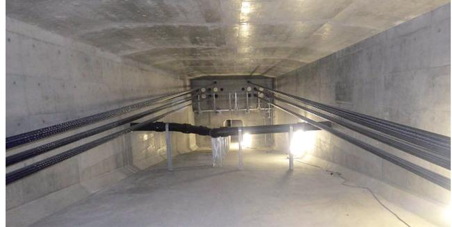
写真-4 外ケーブル施工完了
