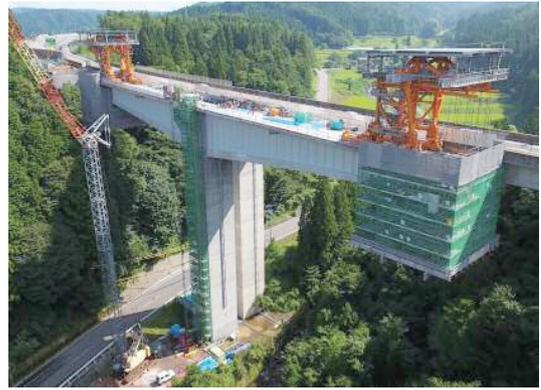
写真-1 大型移動作業車
