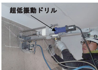
写真-3 削孔状況 (削孔径 15.5mm)
