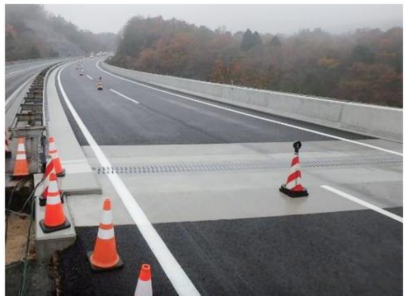
写真-6 床版取替え完了(上り線)
