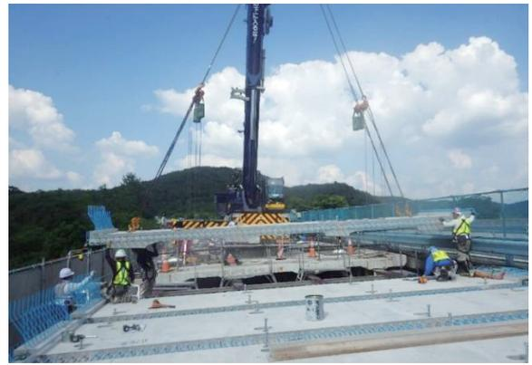
写真-5 PCaPC床版の架設状況
