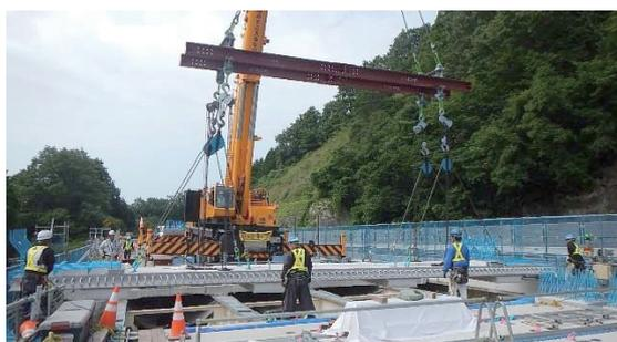
写真-2 PCaPC 床版架設状況
