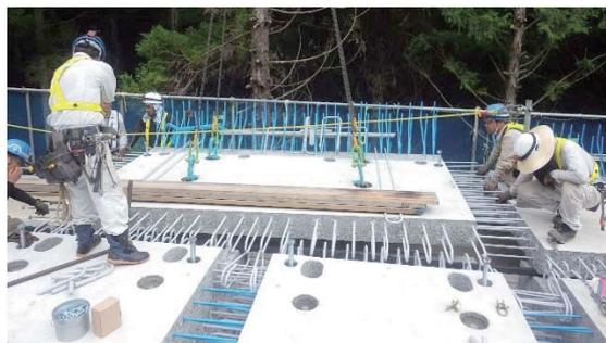
写真-1 張出し床版施工状況
