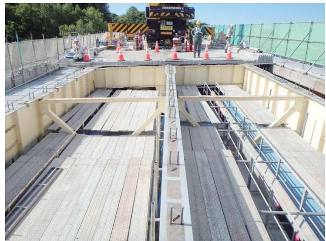
写真-2 スタッドジベル溶接完了状況
