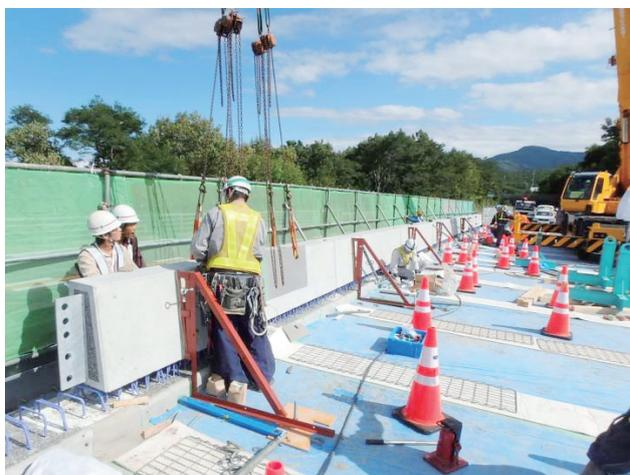
写真-4 DAK式壁高欄プレキャスト部材設置状況
