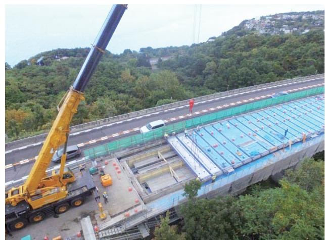
写真-3 PCaPC床版架設状況
