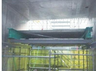
写真-4 型枠移動機構
