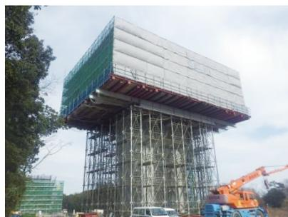
写真-1 柱頭部支保工施工
