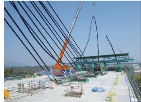
写真-12 斜材の架設
