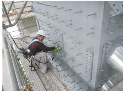
写真-10 添接部の施工
