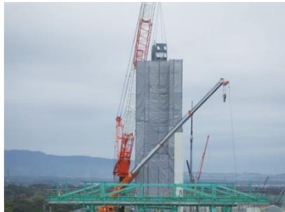
写真-9 鋼殻の据え付け
