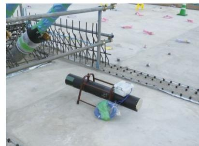
写真-14 温度計測ダミー斜材
