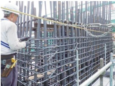
写真-6 主塔鉄筋組立て
