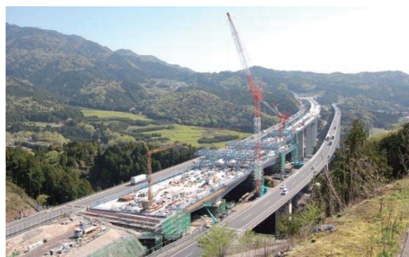
写真-3 施工状況全景
