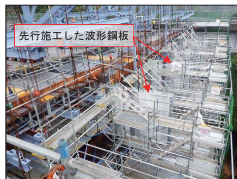
写真-2 波形鋼板ウェブの先行架設状況
