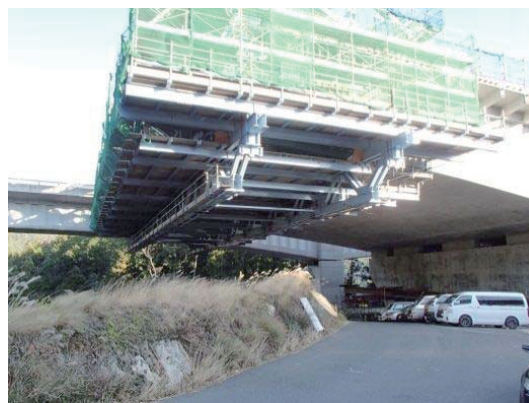
写真-1 張出し施工状況写真
