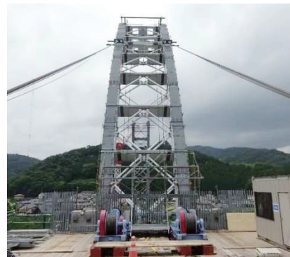
写真-3 3次ロアリング状況
