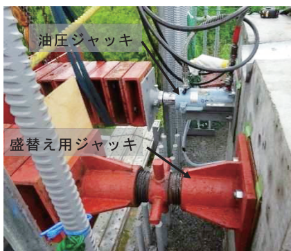
写真-1 1次ロアリング状況
