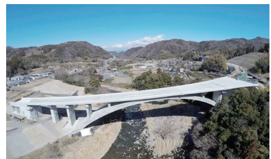
写真-5 完成写真
