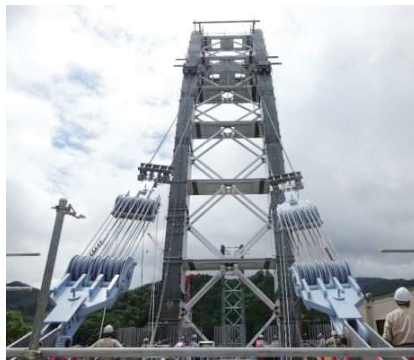
写真-2 2次ロアリング状況
