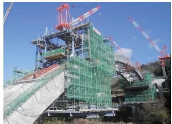
写真-4 移動作業車全景
