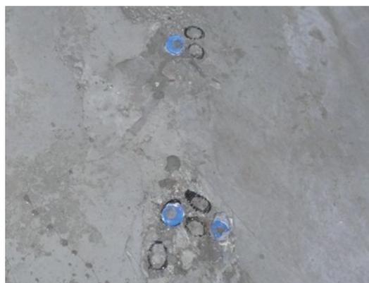
写真-4 ホース切断面の処理例(ドイツ)
