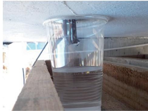
写真-5 漏水状況の一例
