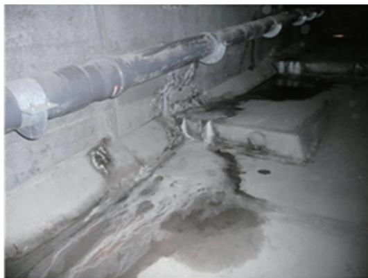
写真－1 伝い水による漏水例
