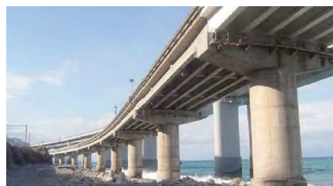
写真-1 旧歌高架橋の全景（一部）
