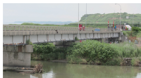
写真-3 旧築別橋の全景 （載荷試験径間側）
