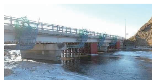
写真-2 旧二雁別橋の全景
