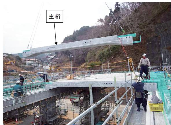
写真-4 主桁架設
