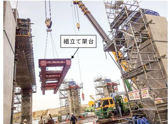
写真-3 受梁組立て架台移動
