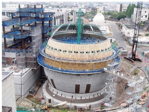
写真－3 側壁の施工状況（赤道より上側）
