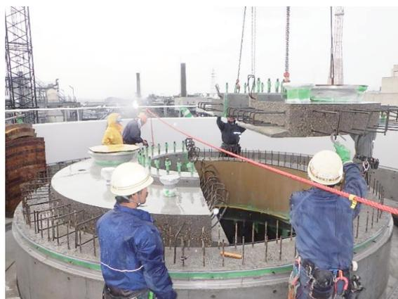
写真－4 ガスドーム部の施工状況
