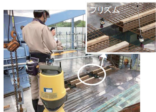
写真-1 型枠セット測量状況
