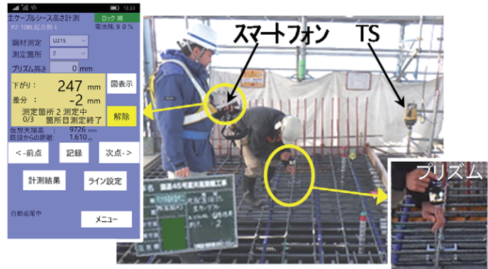
写真-2 PC鋼材配置高さ検測状況
