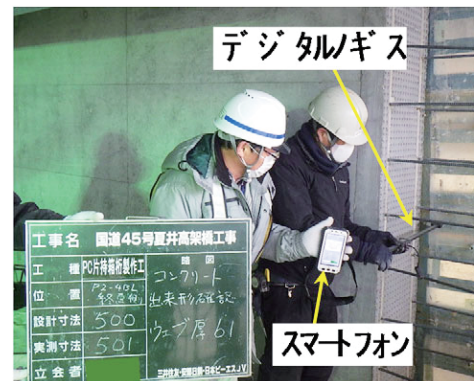
写真-3 出来形検測状況
