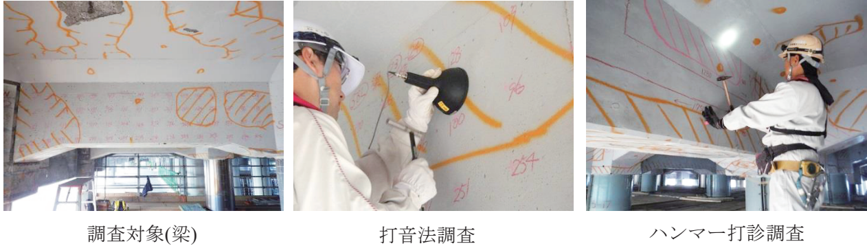
写真-2 実構造物での調査状況
