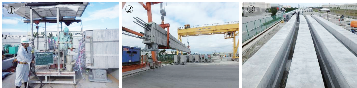
写真-5 ①PC グラウト ②吊り移動 ③ストック
