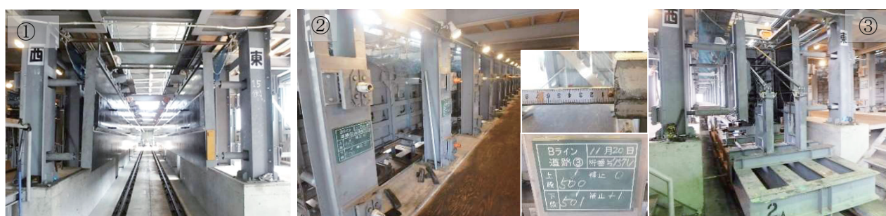
写真-2 モールド装置（①側型枠装置、②調整ジャッキ、③下型枠・端型枠装置）
