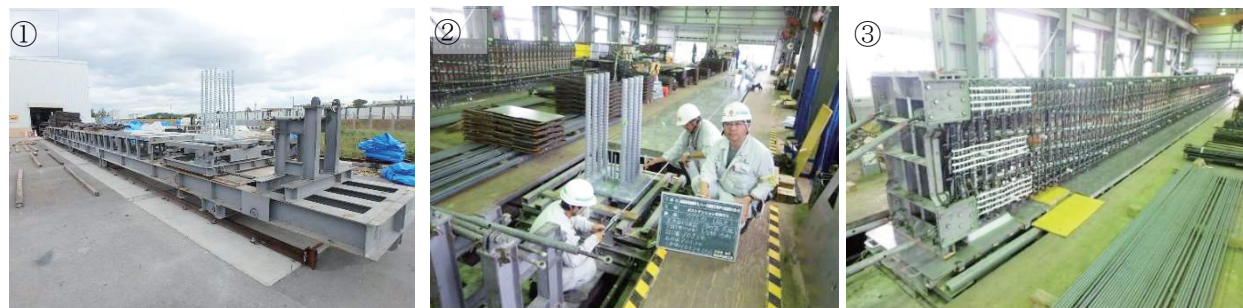
写真-3 ①モールド台車 ②支承セット ③鉄筋・PC・中子枠・端枠組立
