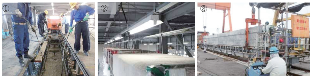
写真-4 ①コンクリート打設 ②養生 ③緊張(1次)
