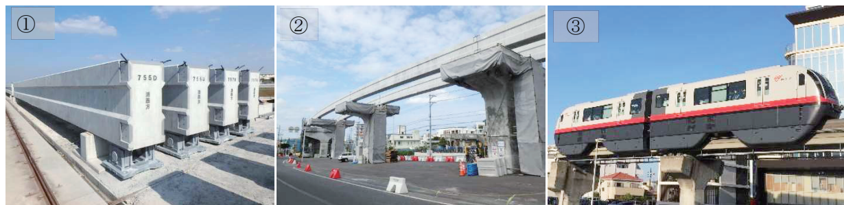
写真-6 竣工（①ストック状況），②架設状況（参考），③供用区間（参考）
