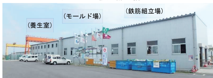
写真-1 PC 軌道桁製作場
