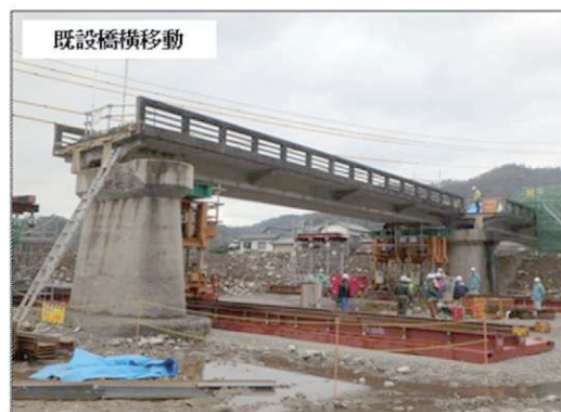
写真－4 既設桁横移動状況
