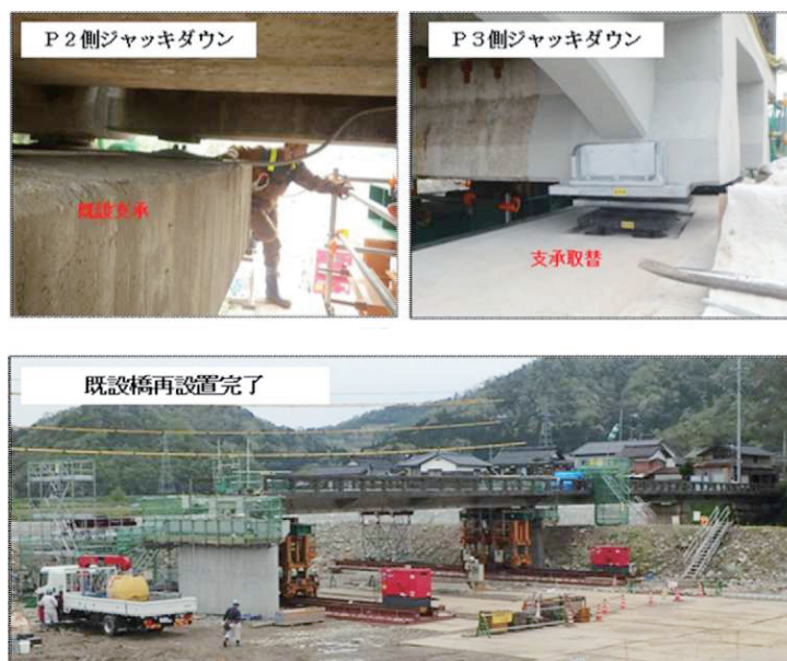
写真－6 既設桁再設置状況
