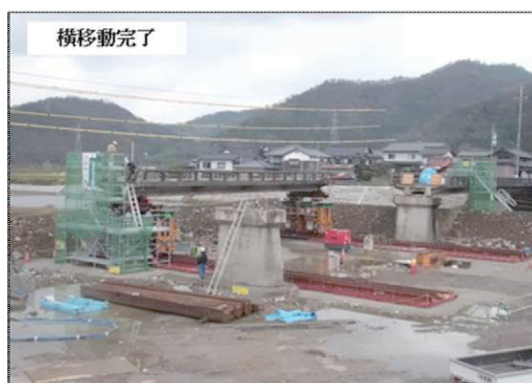
写真－5 既設桁横移動完了
