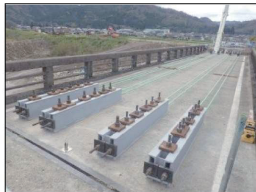
写真－2 PC鋼棒補強配置状況
