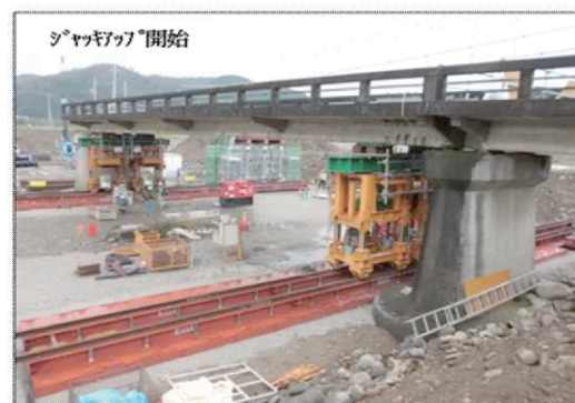
写真－3 ジャッキアップ状況
