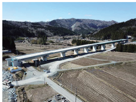
写真-1 横川高架橋完成写真
